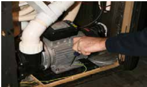
Retirer les moteurs, pompes, l'électronique, et le ventilateur et les entreposer dans un endroit chaud et sec
