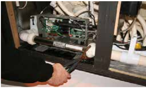
Débrancher l'entrée et la sortie des unions au boîtier de contrôle
