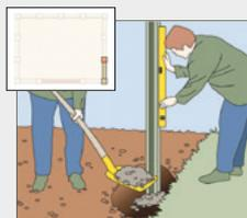
Betonelemente immer waagrecht montieren. Anfangspfosten einbetonieren (Kies, Sand-Zement-Gemisch; Betongüte C 16/20 - erdfeucht). Auf lotgenaues Ausrichten achten.
