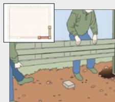
Erste Betonplatte nach gewünschter Flucht in Nut setzen. Ende der Platte mit Pflasterstein unterlegen: Platte in Waage und fest auflegen.
