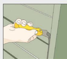
Für ein einheitliches Bild: Platten mit Hebel ausrichten. Bearbeiten (kleinere Abbrüche oder Haarrisse) mit Spachtelmasse ausbessern. Fugen mit Fugenmörtel verfüllen und glätten.
