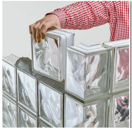
Ideal auch zum Setzen von Glasbausteinen.
