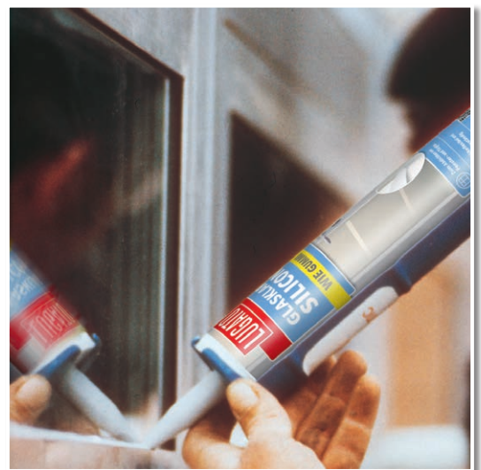
Fensterfalzversiegelung zwischen Glas und Aluminiumrahmen.
