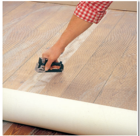
Die Armierung vor dem Ausgleichen mit NEU AUF ALT!.
